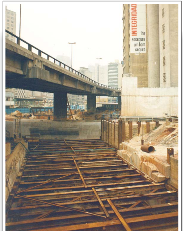
Foto da vala em "cut and cover" e, ao fundo, bloco de sustentação do Pilar 24 do Elevado Costa e Silva
