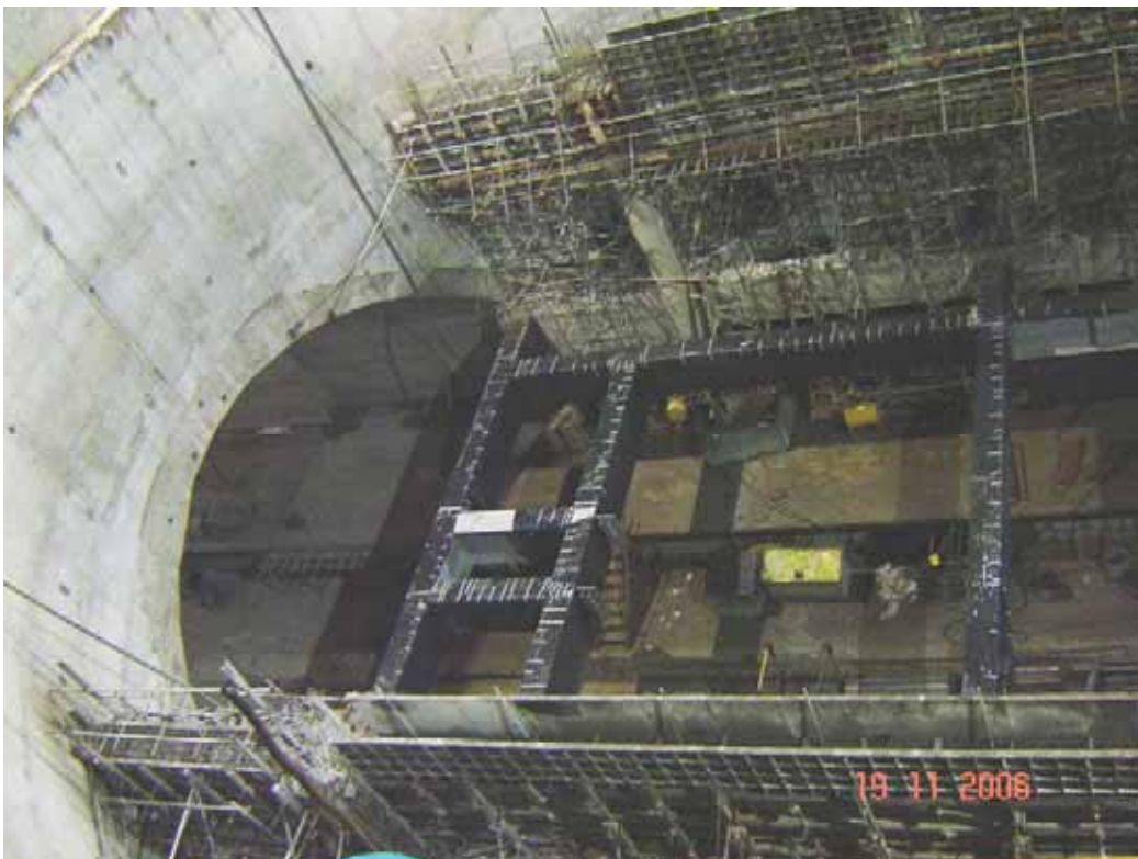
FOTO 29: Fase de montagem da estrutura metálica do mezanino.
