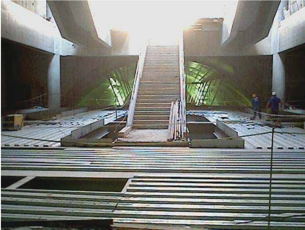
FOTO 30: Fase de montagem do steel-deck.
