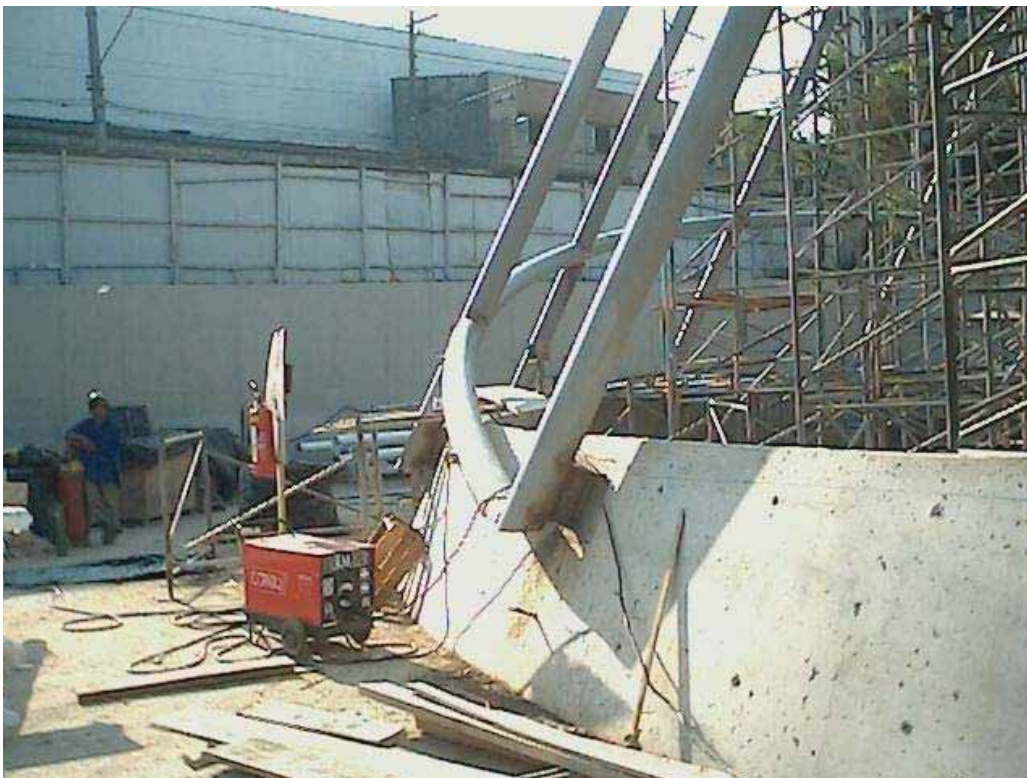
FOTO 31: Fase de montagem da estrutura tubular da cúpula.
