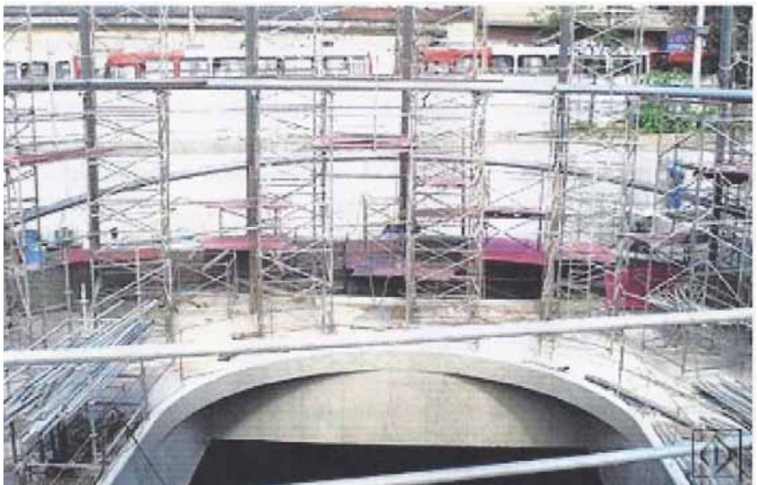
FOTO 33: Fase de montagem da estrutura tubular da cúpula.
