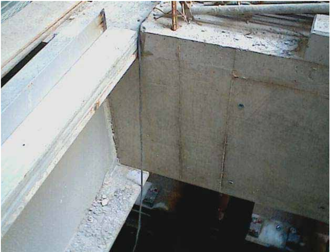
FOTO 7: Apoio da viga da escada na estrutura metálica do mezanino.
