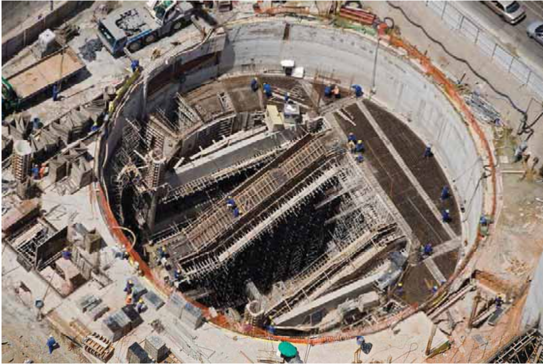
FOTO 28: Fase Executiva da estrutura interna ao poço de acesso.
