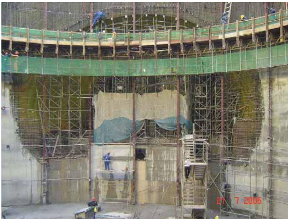
FOTO 27: Forma deslizante na execução das paredes de segunda fase do poço, na região do túnel da Estação.
