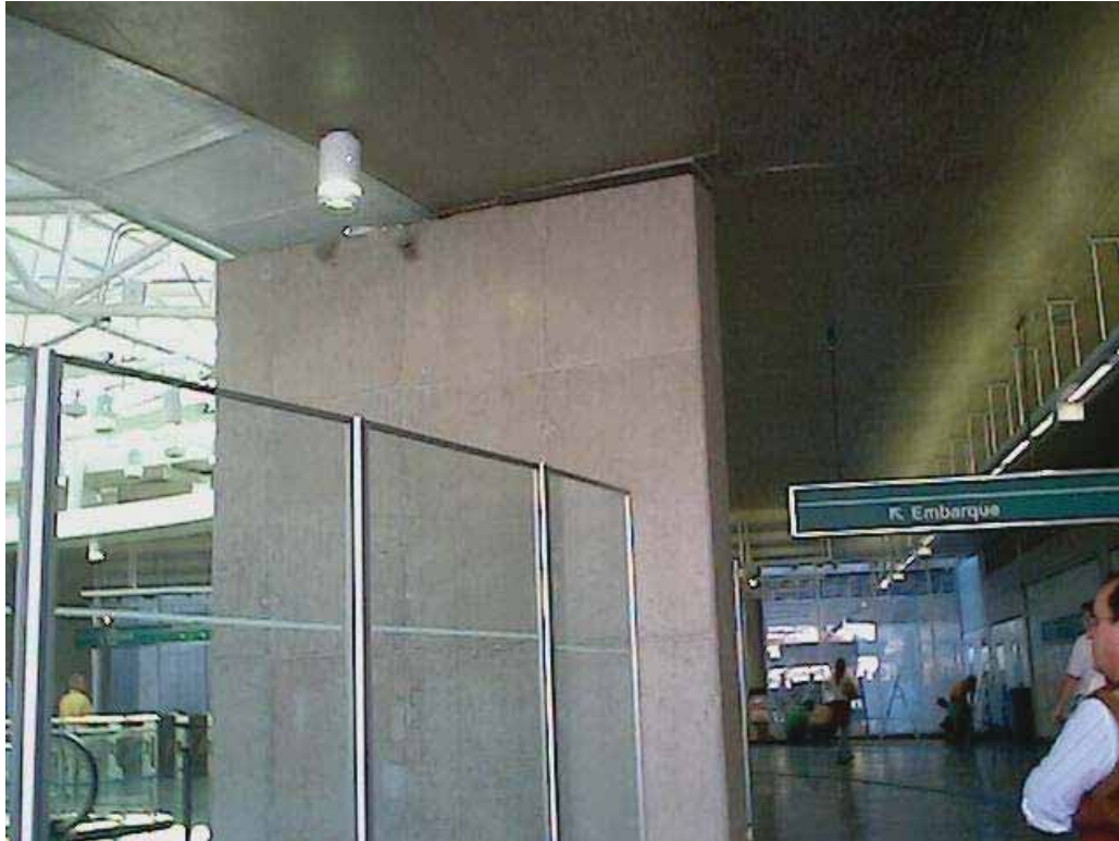
FOTO 16: Vista do pilar parede, que apoia o teto plano.
