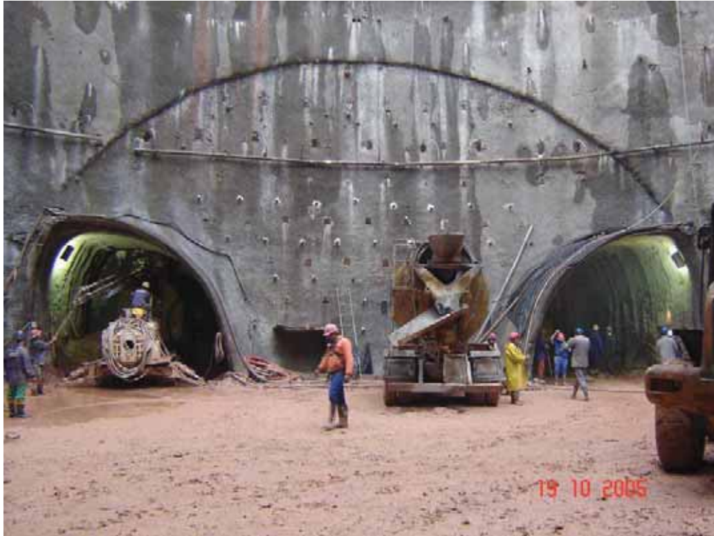
FOTO 20: Fase de execução dos túneis auxiliares (side drift).
