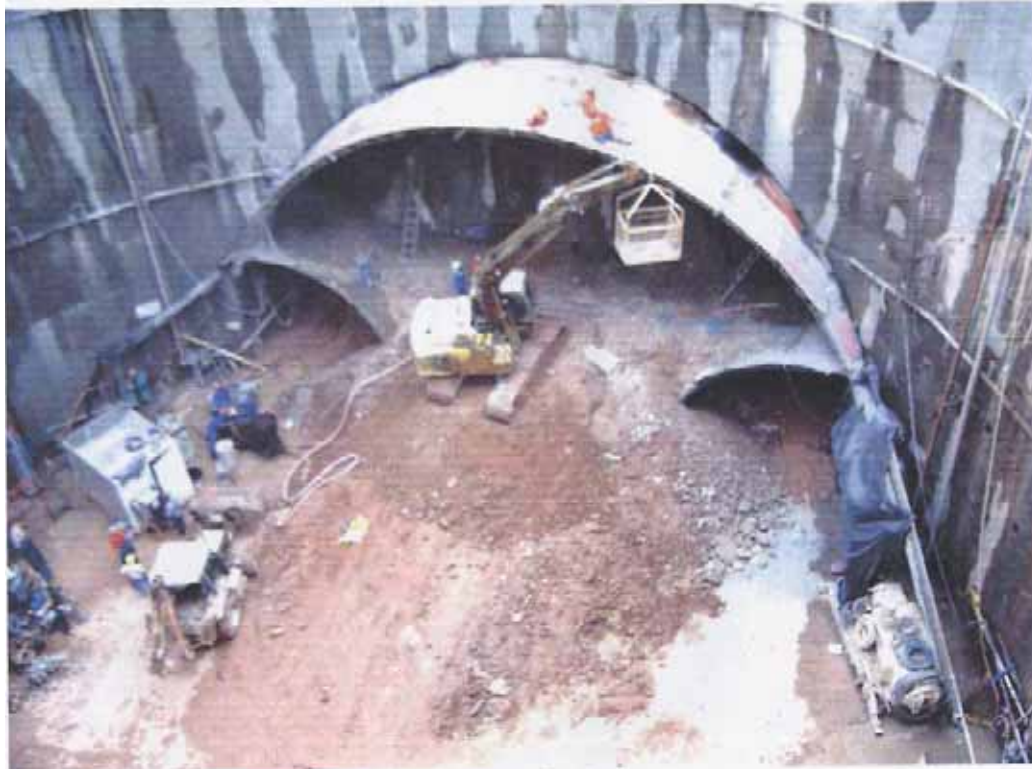
FOTO 21: Fase de execução da calota do túnel.
