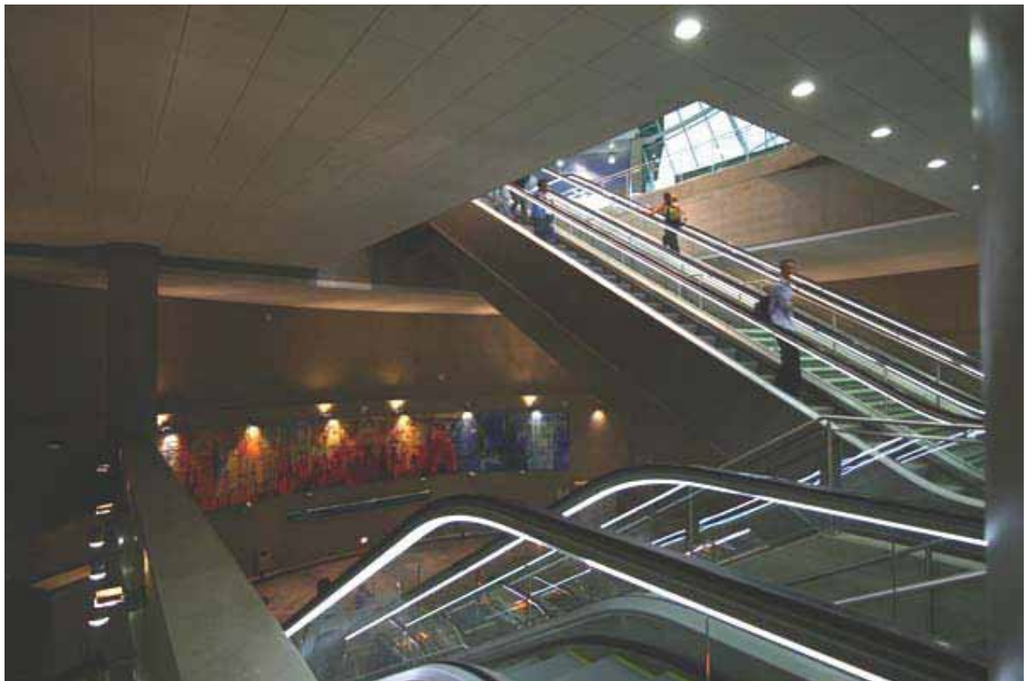
FOTO 1: Vista dos pisos intermediários.
