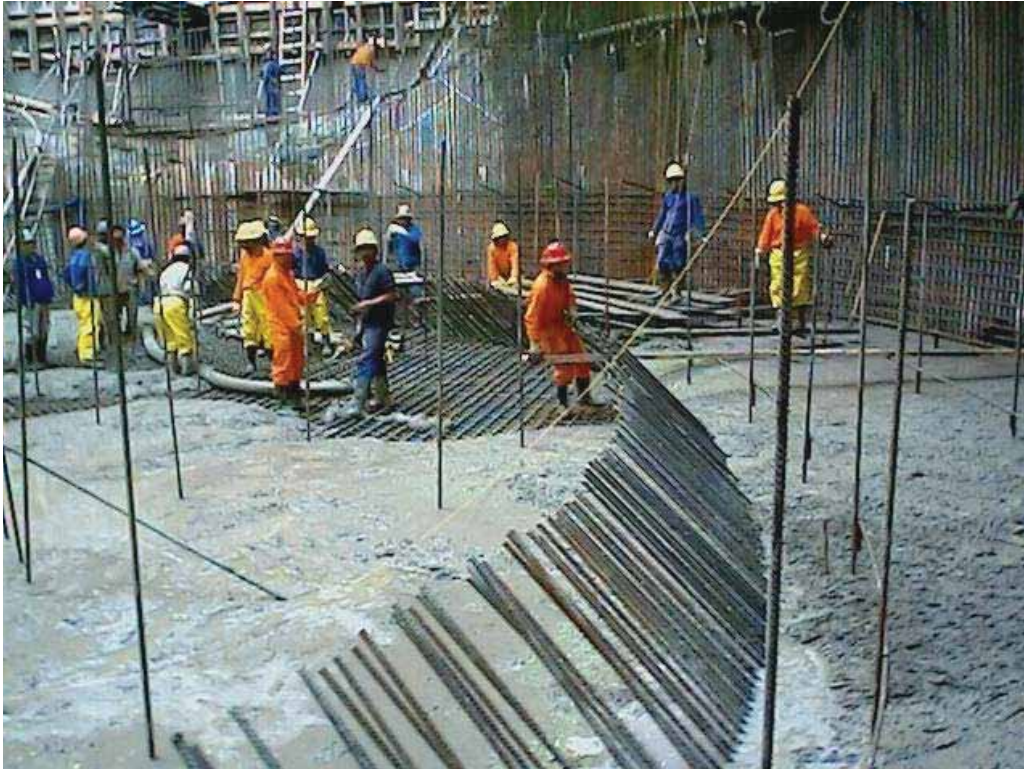
FOTO 24: Fase de concretagem dam primeira etapa da laje de fundo.
