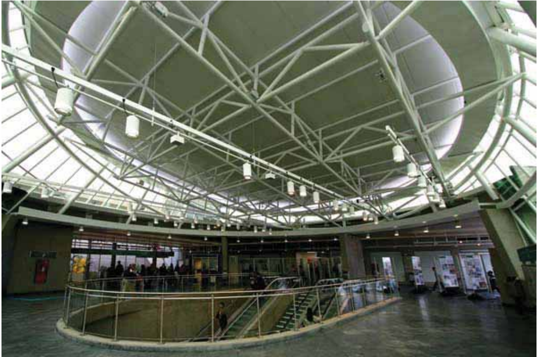
FOTO 10: Vista da cobertura metálica e escadas de acesso.
