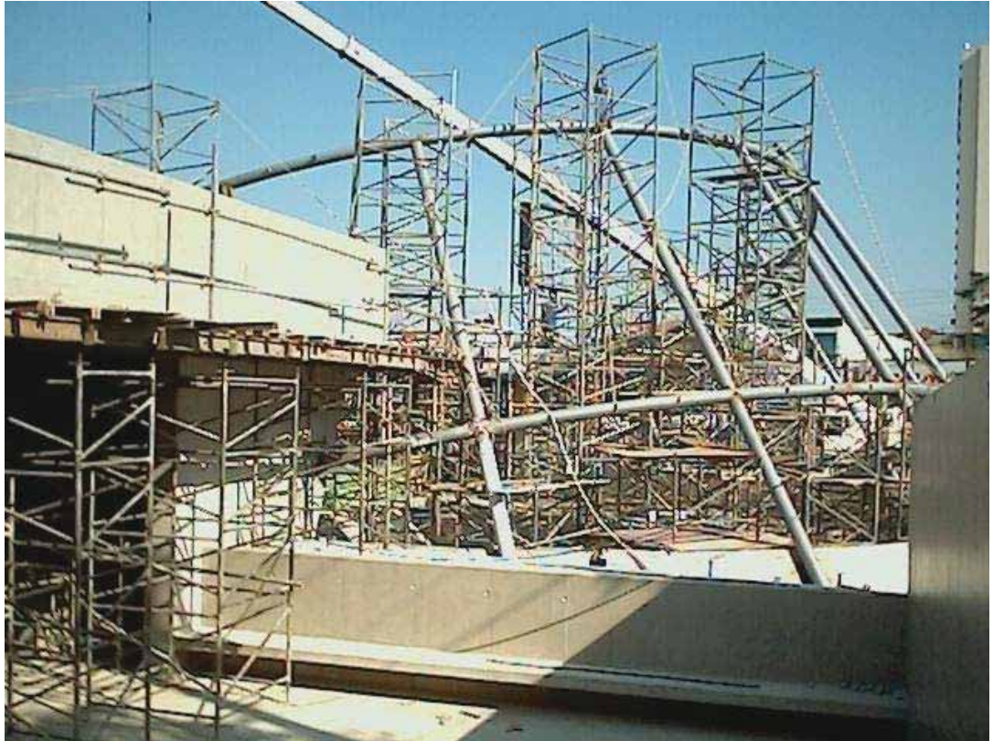
FOTO 32: Fase de montagem da estrutura tubular da cúpula.
