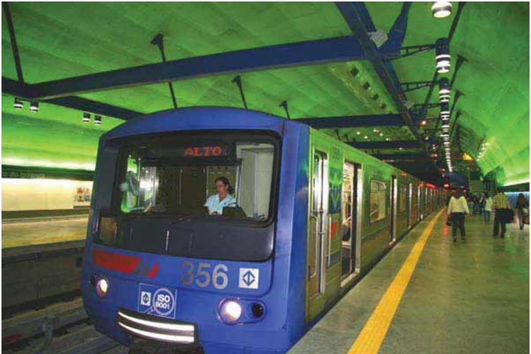
FOTO 8: Vista da Plataforma na região do túnel.
