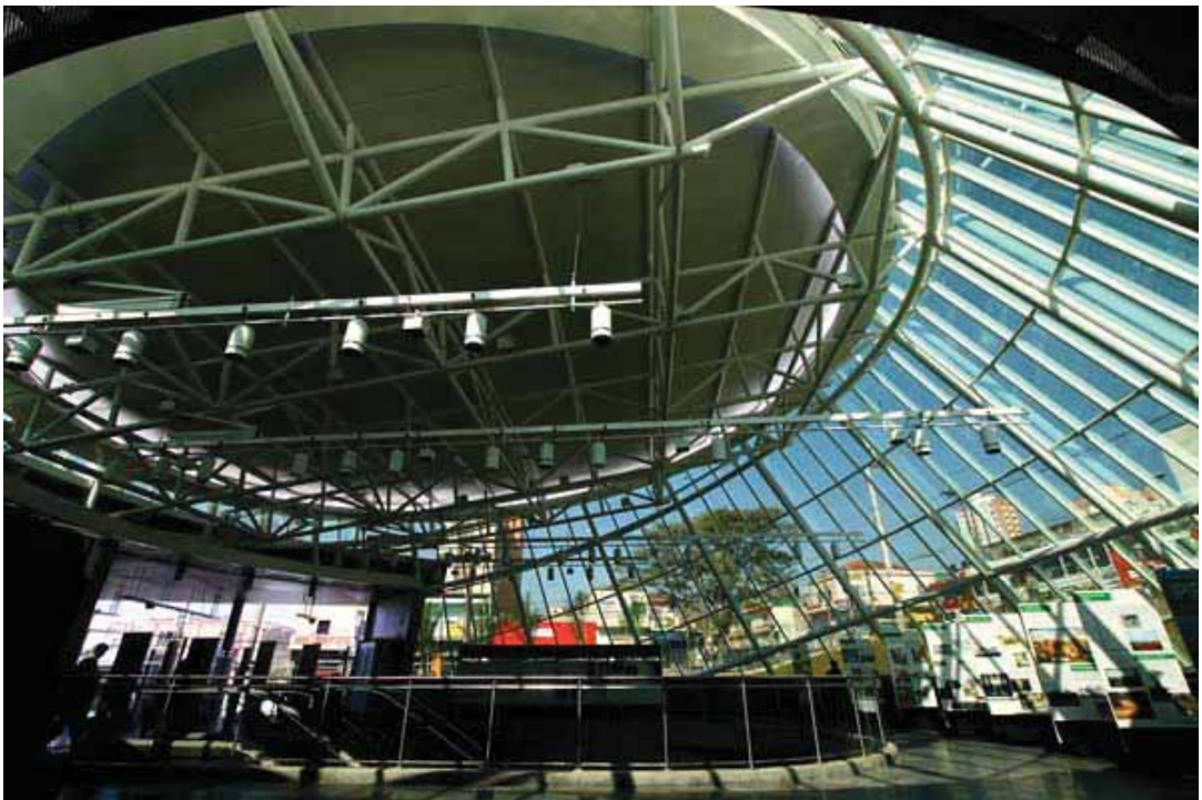
FOTO 9: Vista da cobertura metálica.
