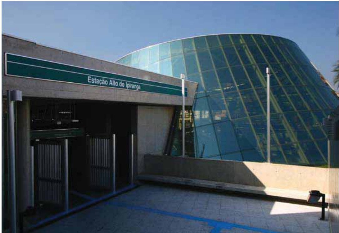
FOTO 14: Vista do acesso Visconde de Pirajá.
