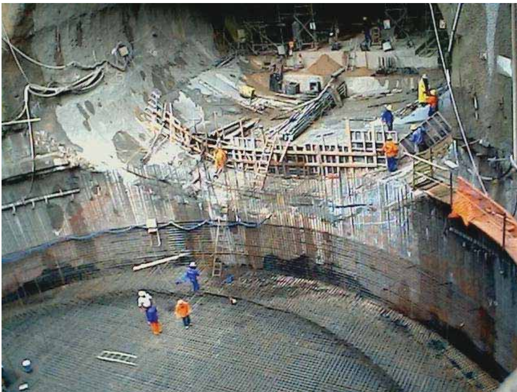
FOTO 25: Armação negativa da laje de fundo do poço.
