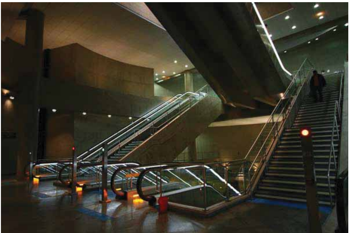
FOTO 2: Vista dos pisos intermediários.
