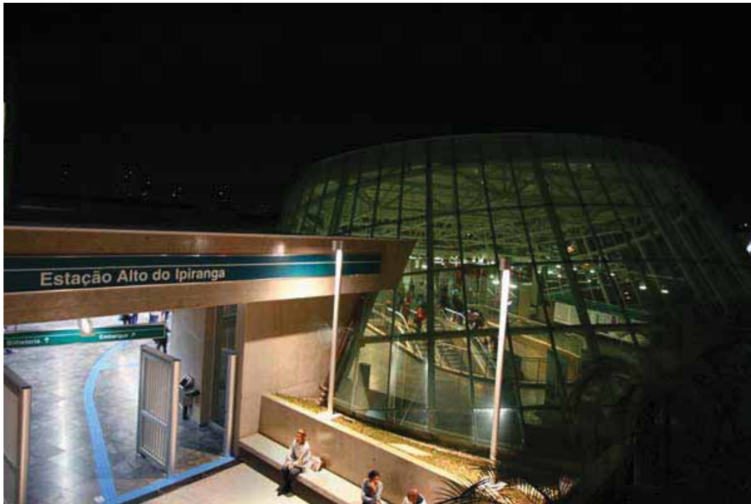
FOTO 18: Vista da torre da saída de emergência.
