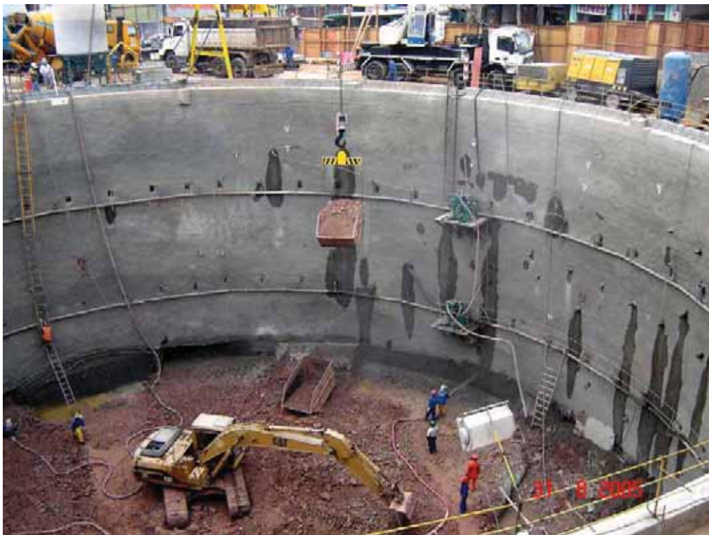
FOTO 19: Fase de Execução da estrutura provisória do poço de acesso.
