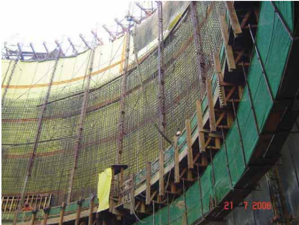
FOTO 26: Forma deslizante na execução das paredes de segunda fase do poço.
