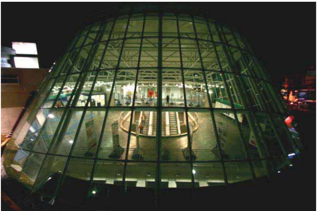
FOTO 11: Vista noturna da cúpula metálica e escadas de acesso.
