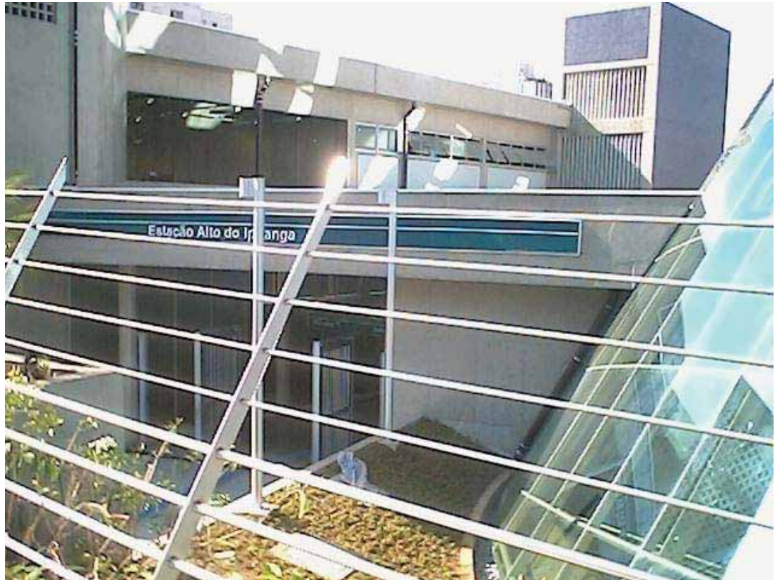
FOTO 12: Vista das salas técnicas, ao fundo.
