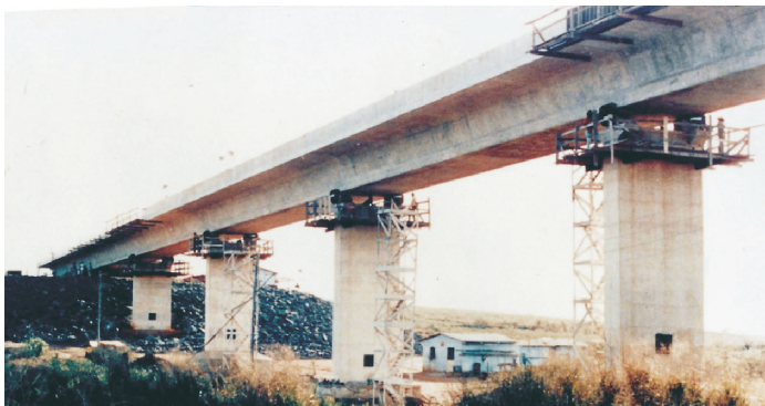
FOTO DA OBRA EM FASE DE LANÇAMENTO
