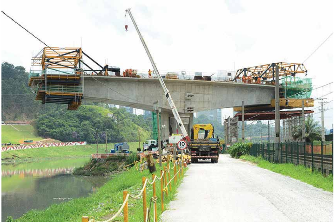
Foto 25 - Frente 2 - Fase 2 - Execução dos Balanços Sucessivos (Aduela 4) [10/2015]
