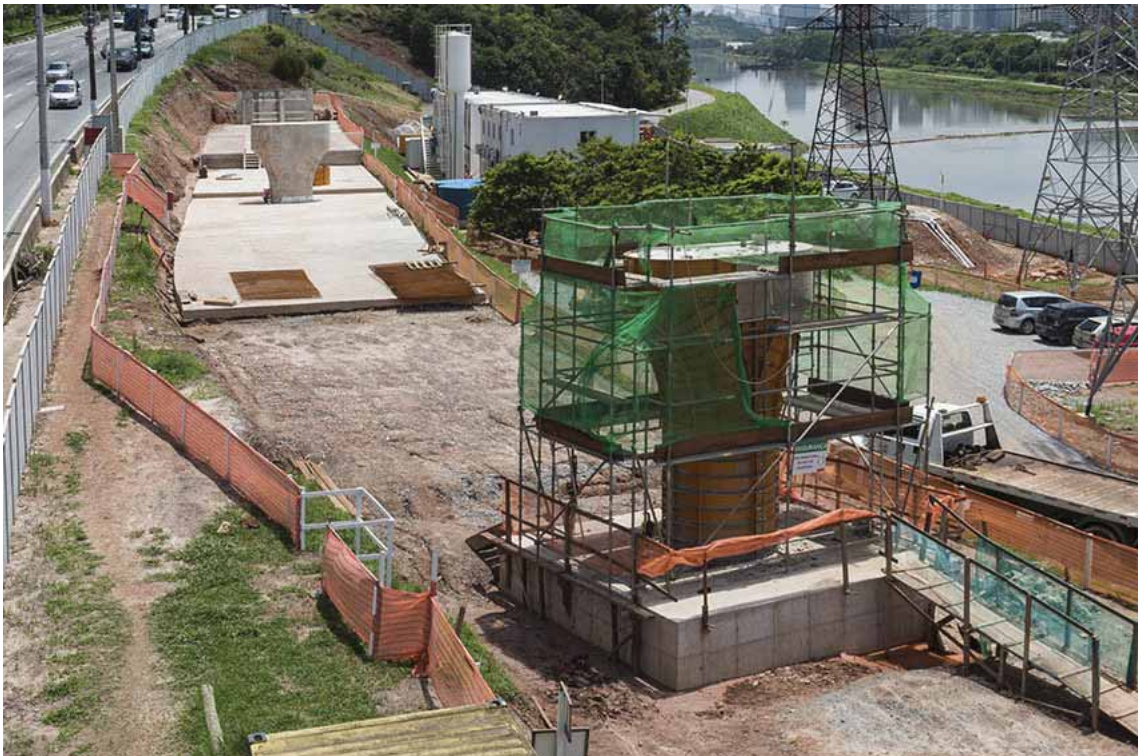
Foto 2 - Frente 1 - Pilar AP1 Ramo 100 finalizado e desforma AP2 Ramo 100 [12/2014]
