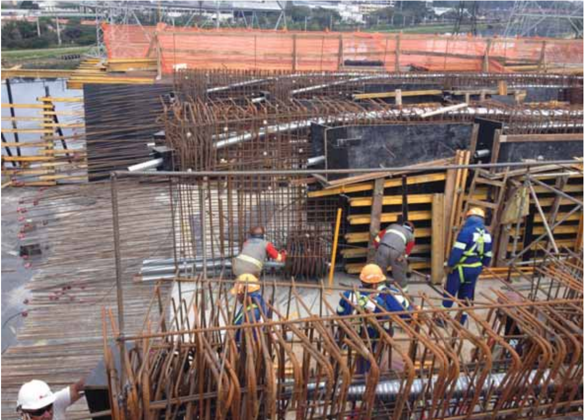
Foto 10 - Fase 2 - Montagem de formas e armação [07/2015]
