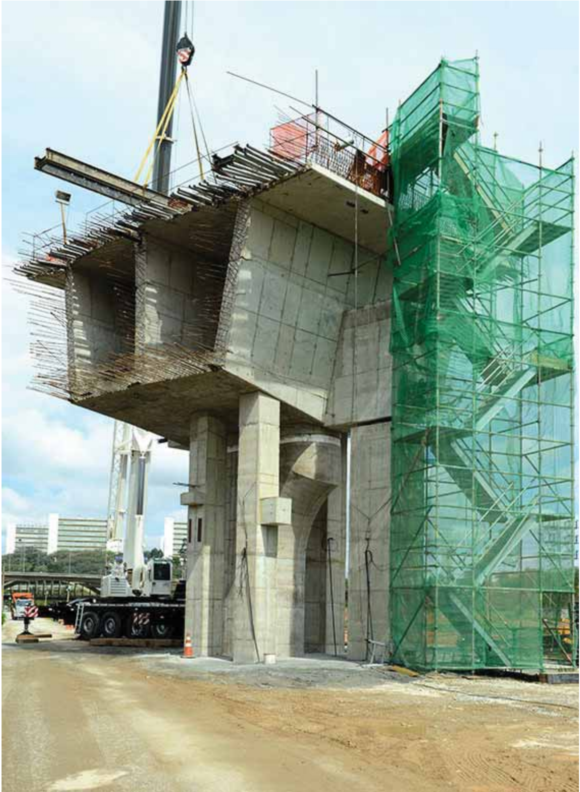
Foto 22 - Frente 2 - Fase 1 – Aduelas de disparo sobre o AP5 finalizadas [08/2015]
