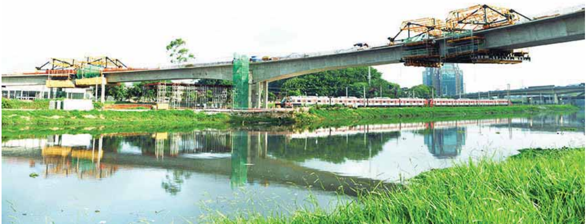
Foto 28 - Frentes 1, 2 e 3 - Execução das aduelas de fechamento entre as frentes 1, 2 e 3 [12/2015]
