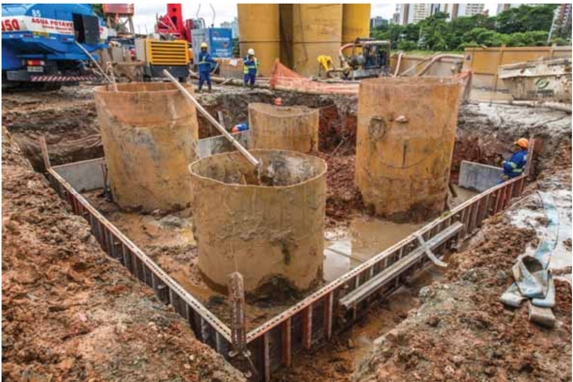
Foto 3 - Execução do bloco do AP4 [02/2015]
