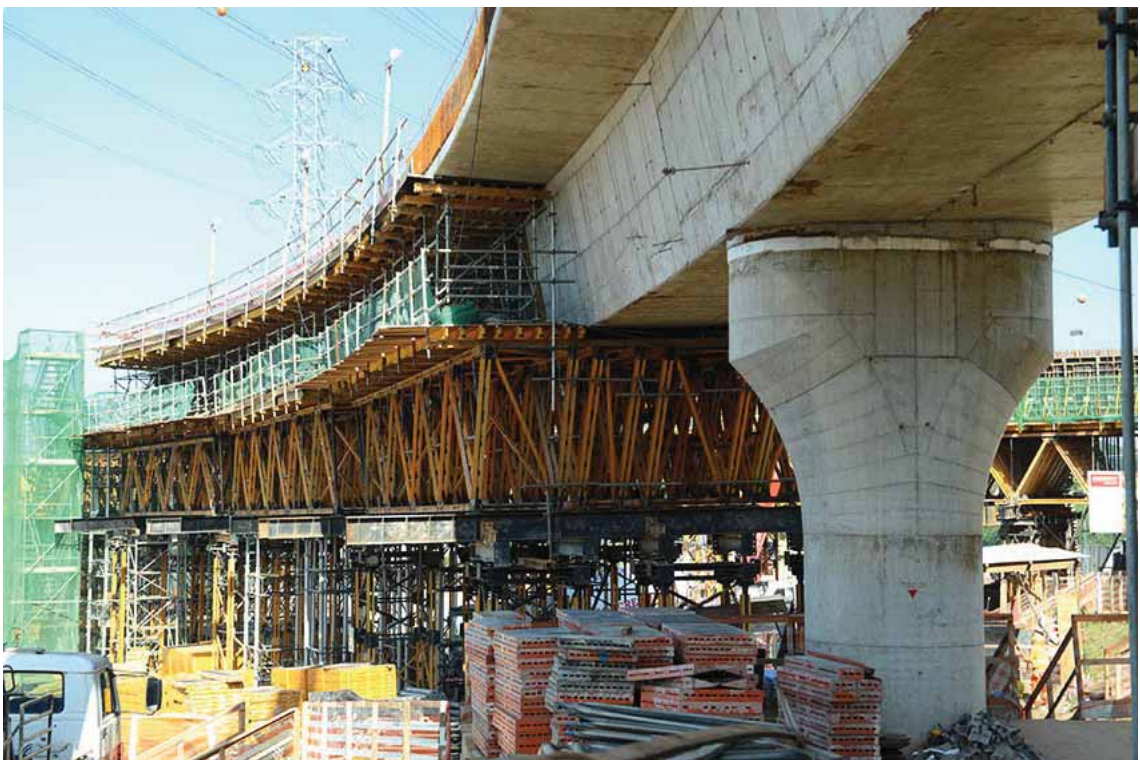
Foto 12 - Frente 1 - Fase 3 - Cimbramento dos vãos entre AP2 Ramo 100/AP3 e AP4 [05/2015]
