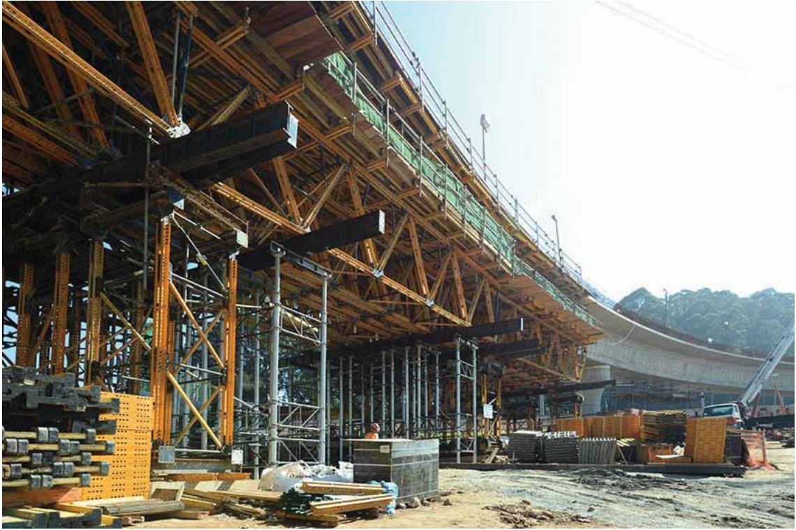
Foto 11 - Frente 1 - Fase 3 - Cimbramento dos vãos entre AP2 Ramo 100/AP3 e AP4 [05/2015]
