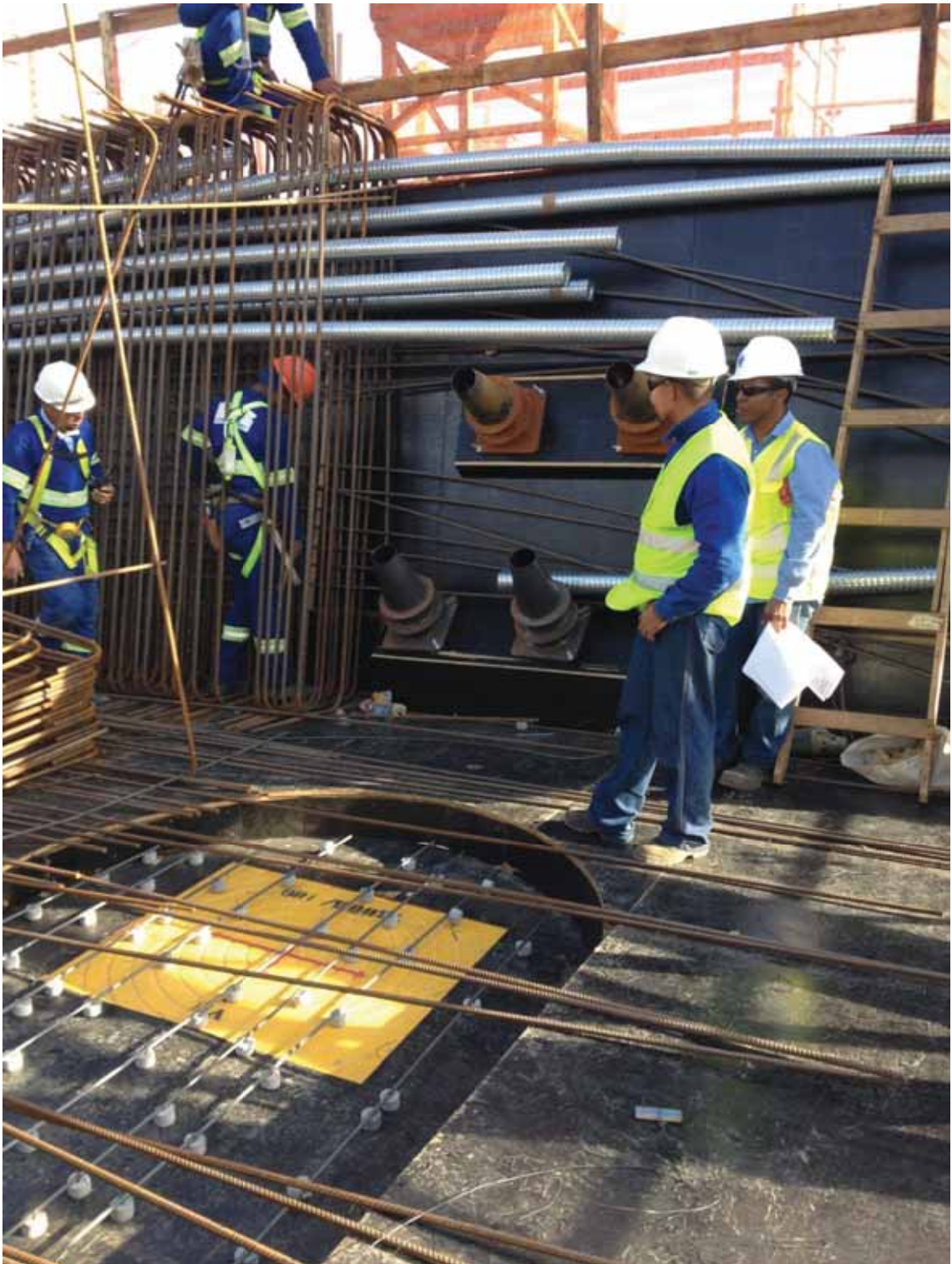
Foto 5 - Fase 5a - Montagem da armação e bainhas de protensão sobre o pilar AP1 [06/2015]
