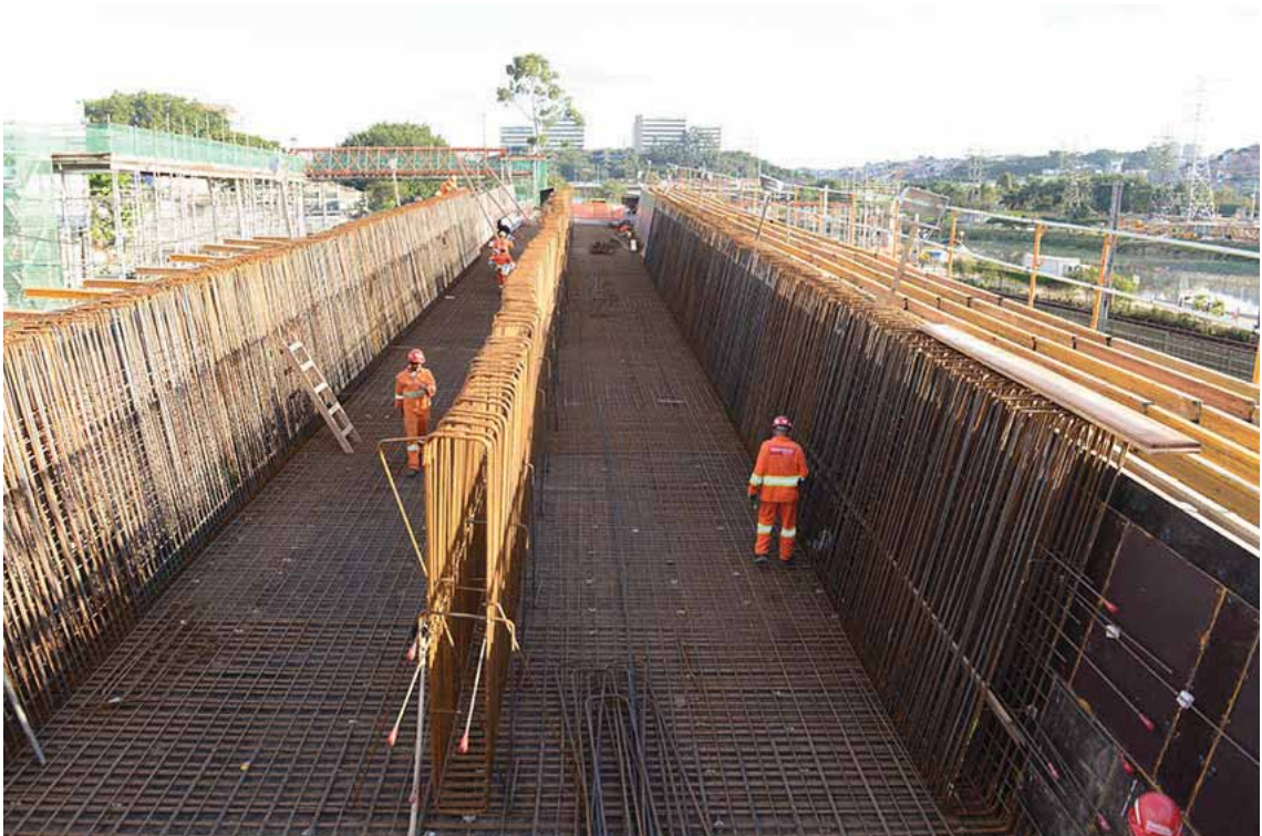
Foto 15 - Frente 3 - Fase 1 - Montagem da armação do vão entre AP6 e E2 [06/2015]
