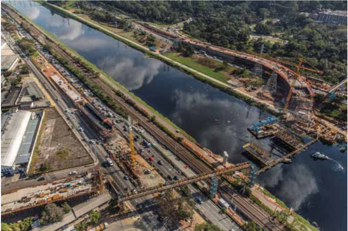
Foto 7 - Fase 2 - Montagem de armação do balanço / Fase 4 - montagem de formas / Fase 5a - finalizada [07/2015]
