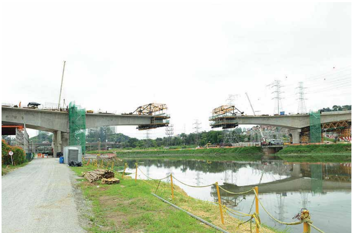
Foto 26 - Frentes 2 e 3 - Execução dos Balanços Sucessivos sobre o Rio Pinheiros [11/2015]
