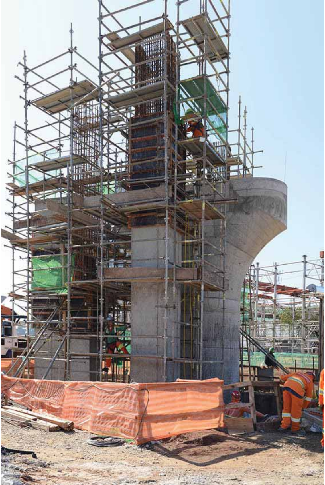
Foto 13 - Frente 2 - Execução dos pilares provisórios junto ao AP5 [06/2015]
