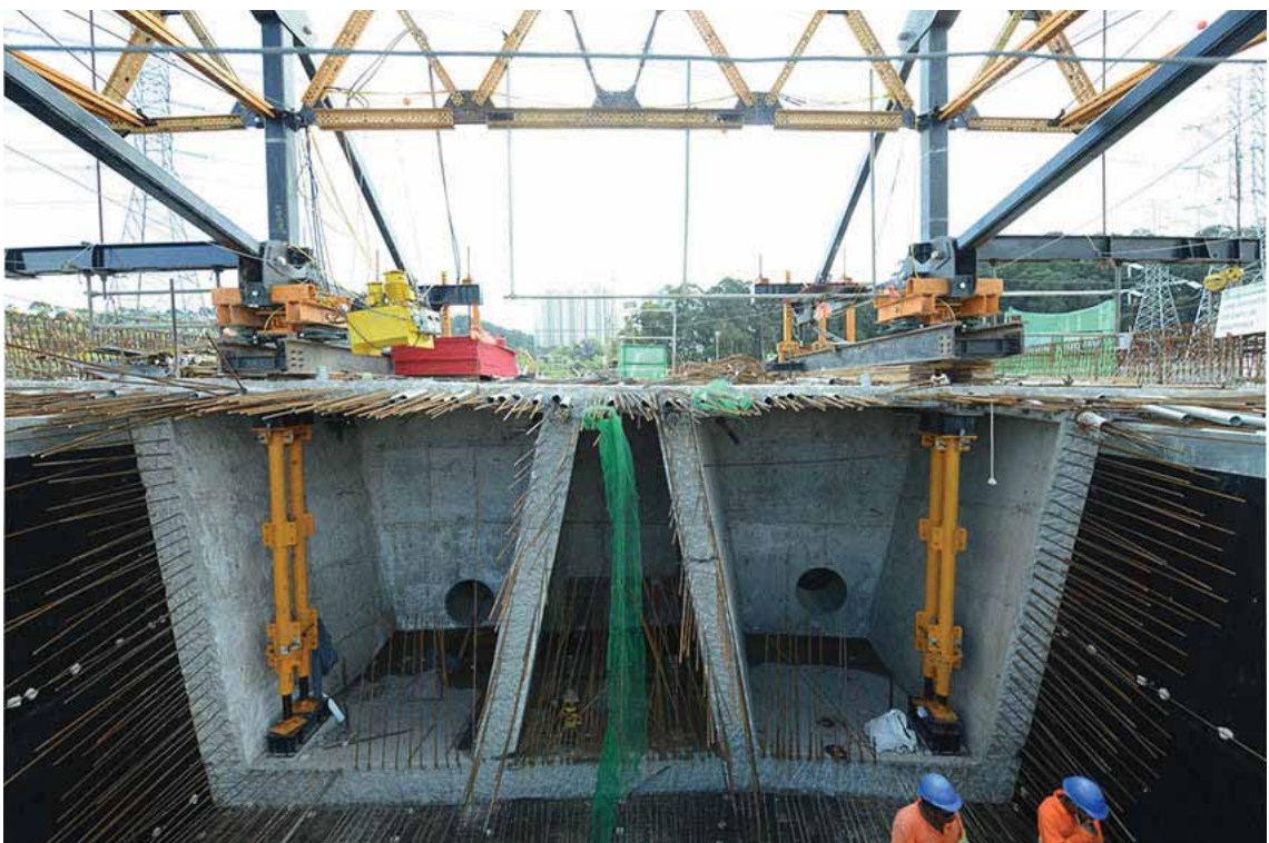
Foto 19 - Frente 1 - Fase 4 - Carro CVS da ULMA Construction posicionado sobre a aduela de disparo do AP4 (detalhe da aduela de disparo) [08/2015]
