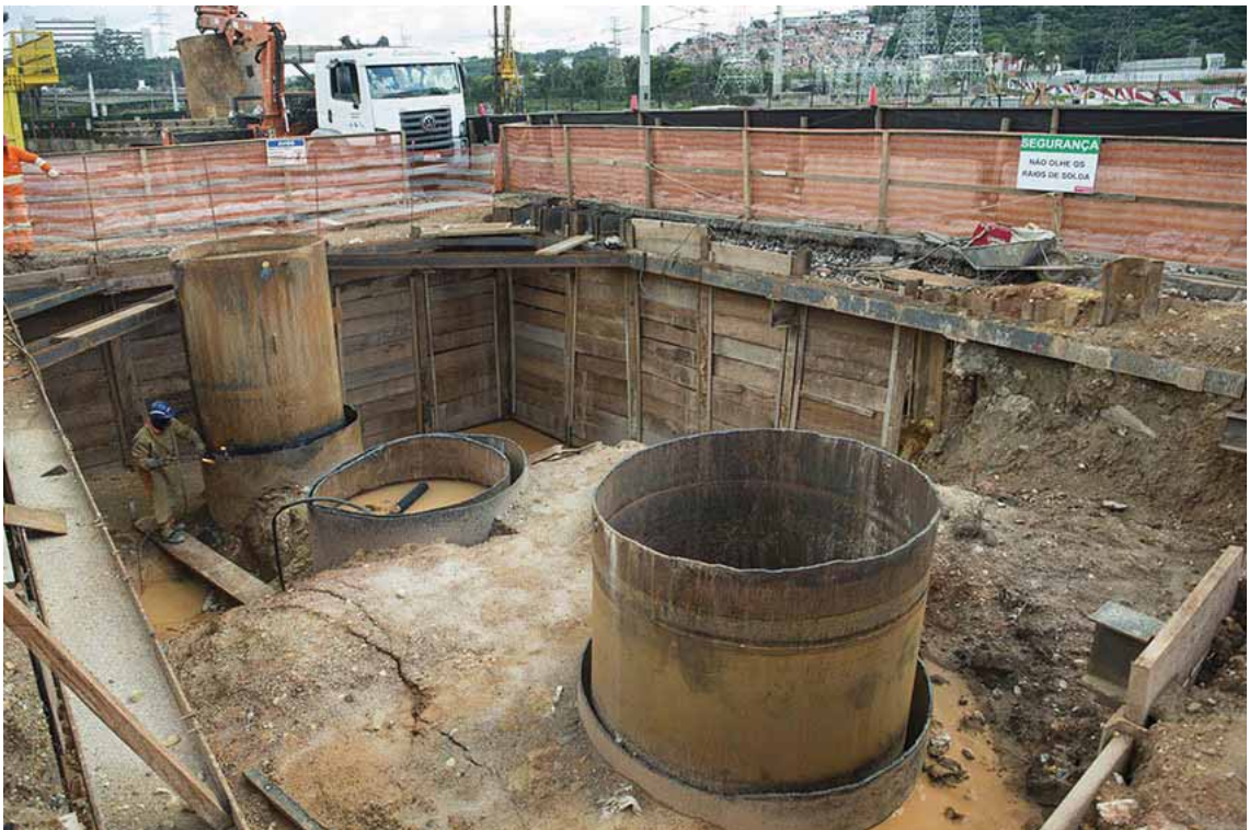
Foto 6 - Frente 3 - Execução do Bloco AP6 [02/2015]
