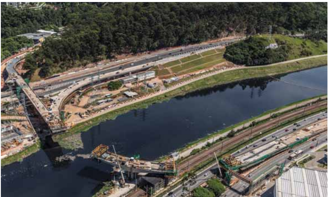
Foto 24 - Frentes 1, 2 e 3 - Execução dos Balanços Sucessivos [10/2015]
