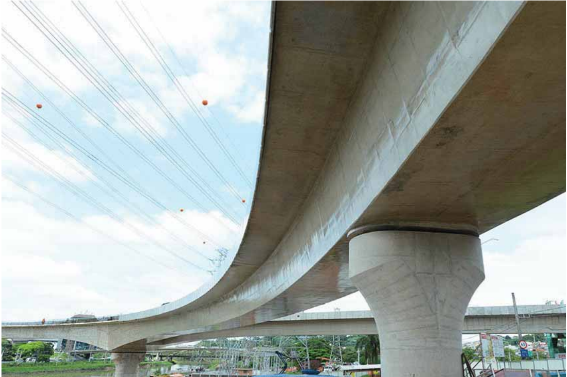
Foto 29 - Vista inferior do vão entre AP2 Ramo 100 e AP4 [03/2016]
