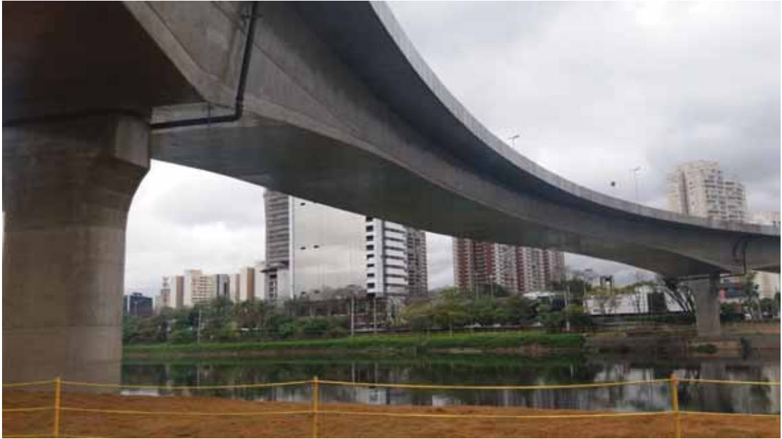
Foto 20 - Vista inferior do vão entre AP2 e AP3 [08/2016]
