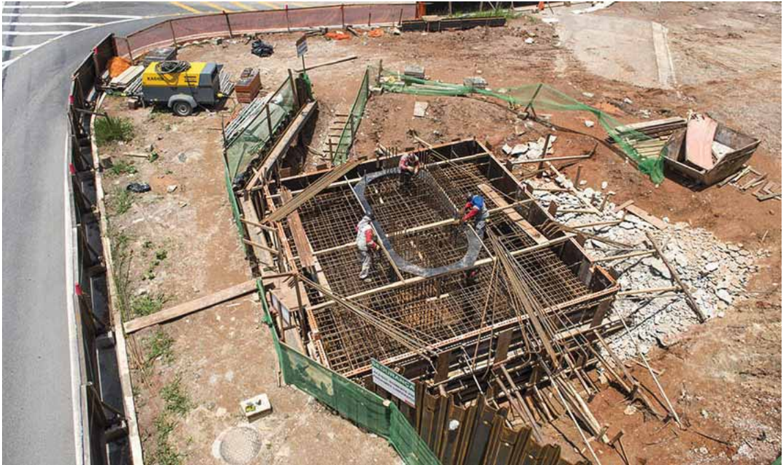
Foto 1 - Ponte 1 - Execução do Bloco AP2 do Ramo Ponte [12/2014]
