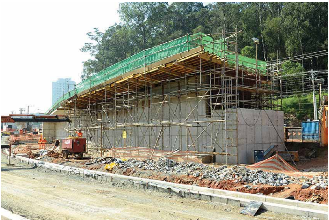
Foto 17 - Caixa 1 - Montagem de armação do tabuleiro do segundo trecho da Caixa 1 [07/2015]
