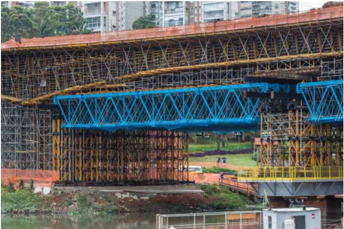
Foto 14 - Fase 3 - Cimbramento vão entre AP2 e AP3 [10/2015]
