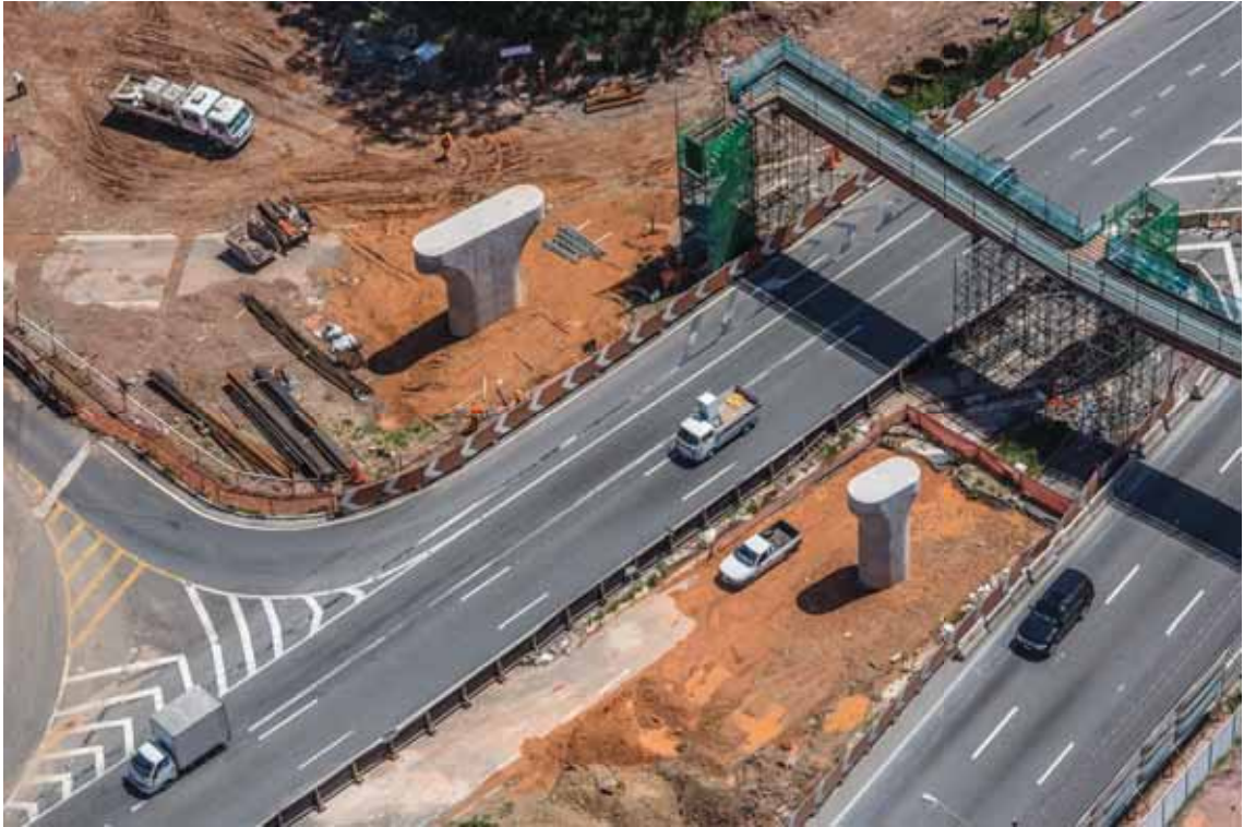
Foto 5 - Ponte 1 - Pilares AP2 e AP3 finalizados [02/2015]
