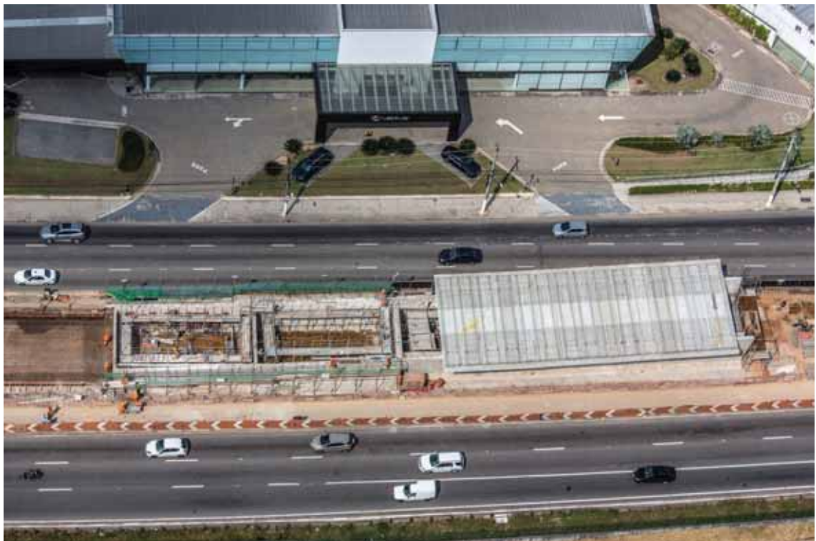
Foto 10 - Caixa 2 - Execução da caixa 2 (colocação dos painéis pré-moldados do tabuleiro) [04/2015]
