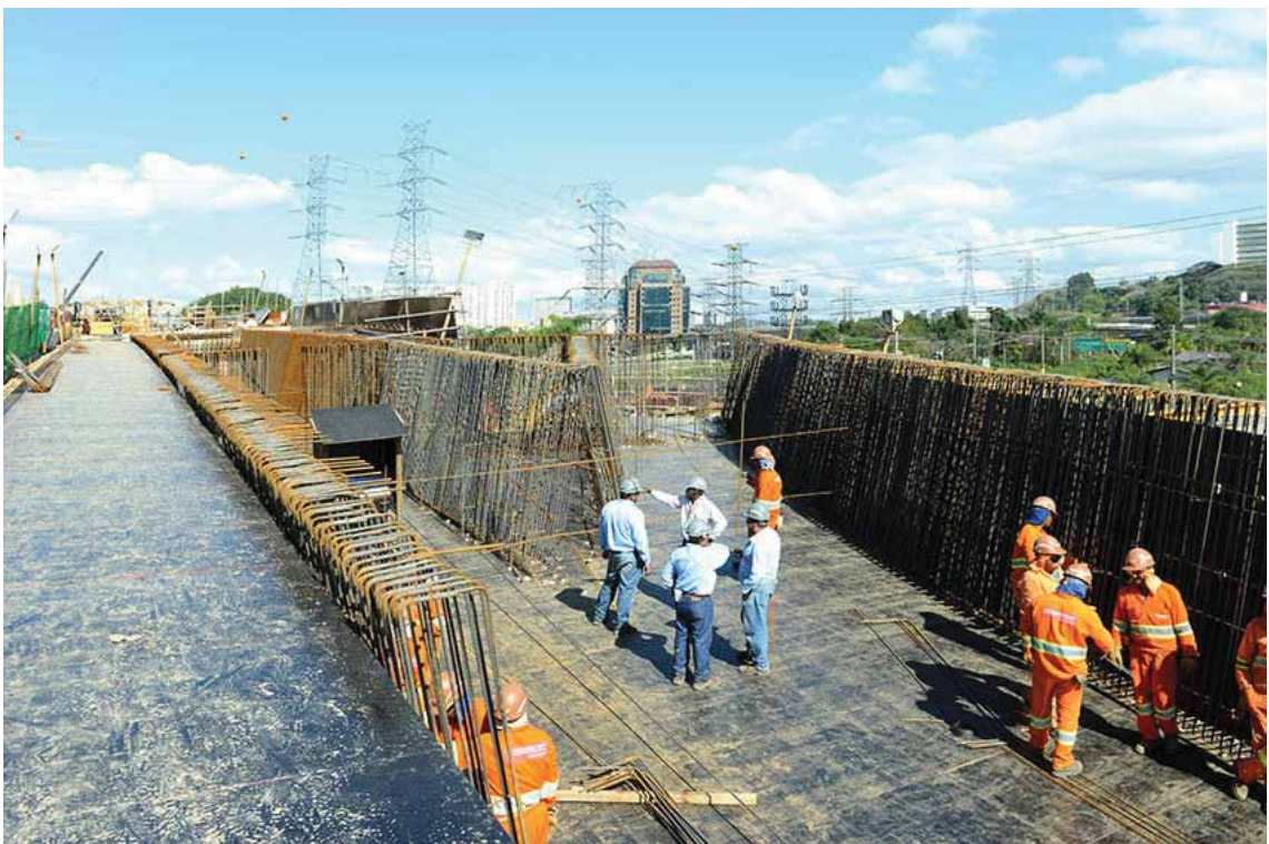
Foto 21 - Ponte 1 - Montagem da armadura na bifurcação da ponte 1 (Ramo Ponte e Ramo 200) [08/2015]
