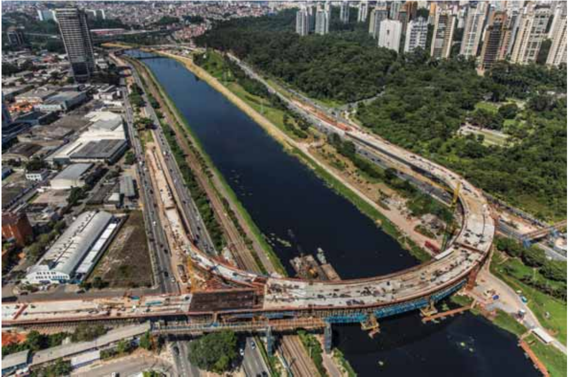
Foto 16 - Fase 7 - parcialmente executada / Fase 6 - executada, porém ainda não solidarizada à Fase 3 [12/2015]
