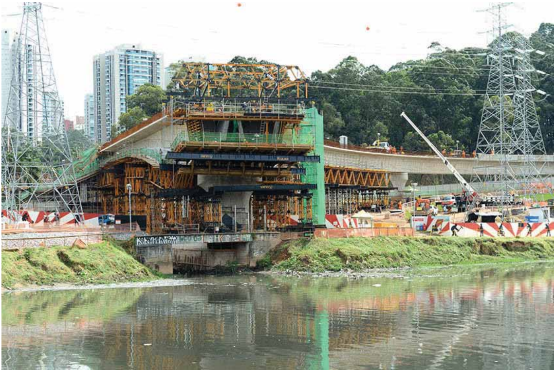
Foto 18 - Frente 1 - Fase 4 - Carro CVS da ULMA Construction posicionado sobre a aduela de disparo do AP4 (vista frontal) [08/2015]
