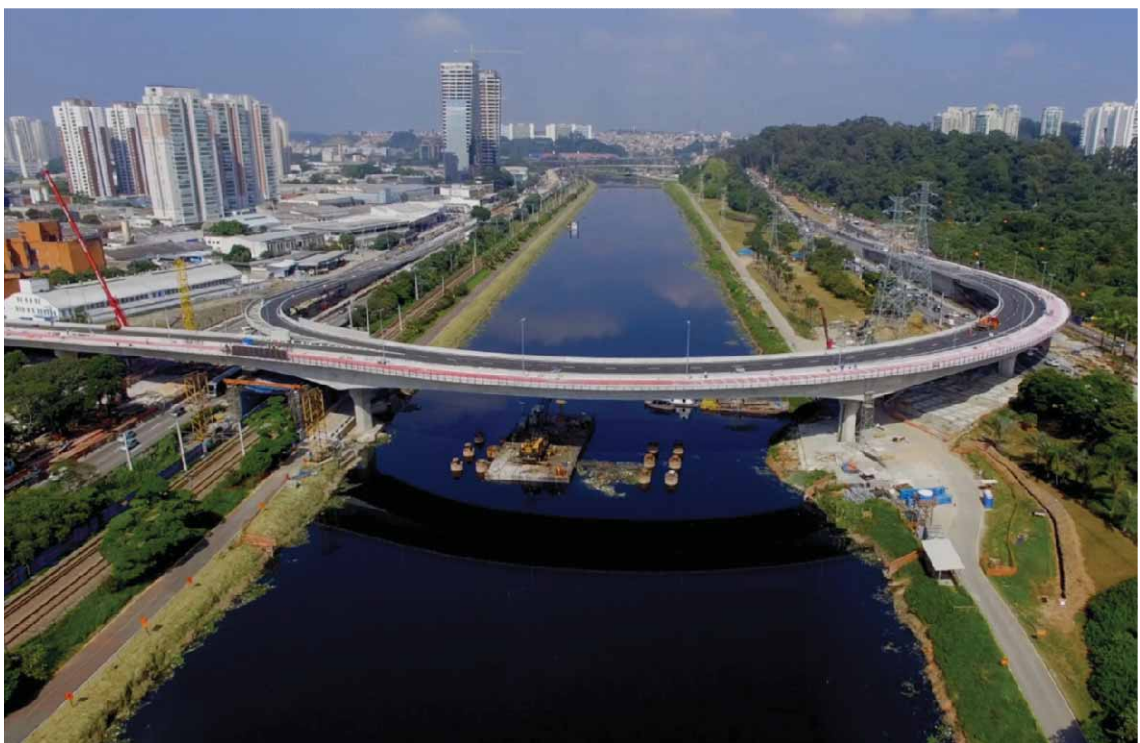
Foto 17 - Obra finalizada e desmonte dos apoios provisórios [04/2016]
