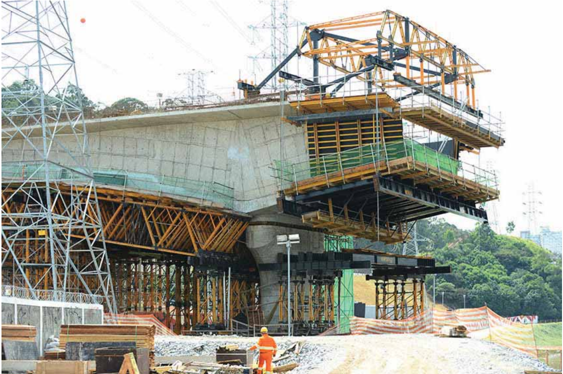
Foto 20 - Frente 1 - Fase 4 - Carro CVS da ULMA Construction posicionado sobre a aduela de disparo do AP4 (Vista lateral) [08/2015]
