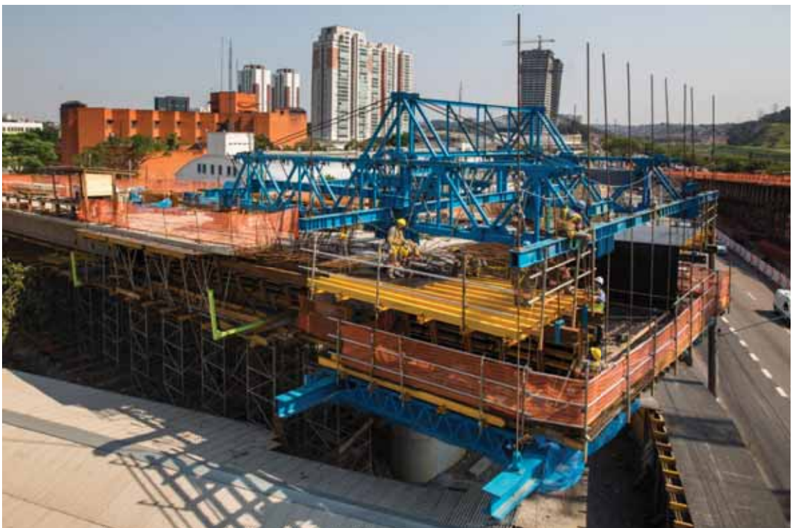
Foto 11 - Fase 5b - Treliça de balanços sucessivos da Protende montada sobre a aduela de disparo [09/2015]
