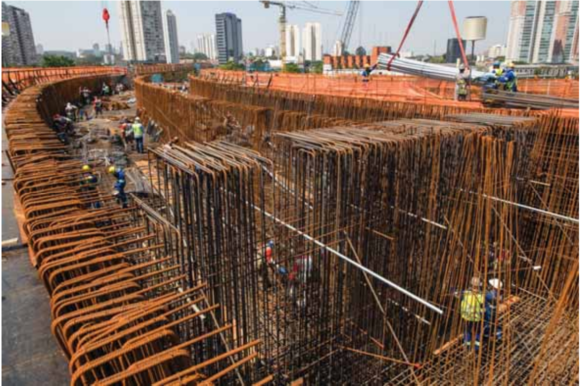
Foto 12 - Fase 2 - Montagem de armação da transversina sobre o pilar AP4 [09/2015]
