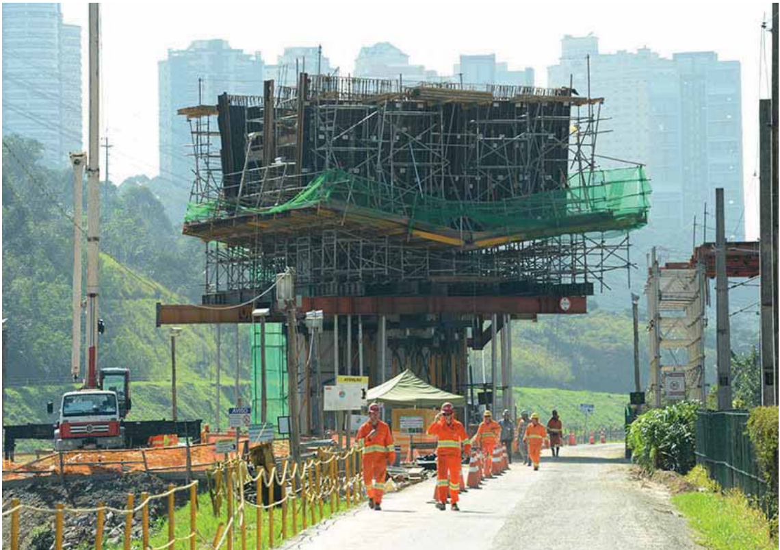
Foto 16 - Frente 2 - Fase 1 - Montagem da armação da aduela de disparo sobre o AP5 [07/2015]
