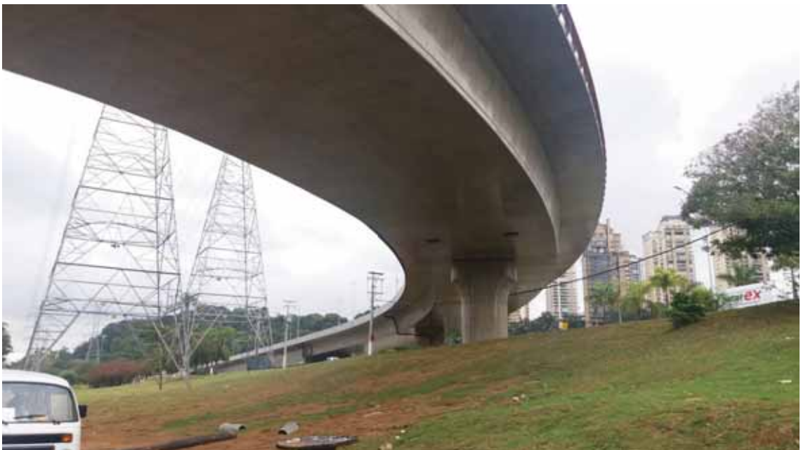
Foto 23 - Vista inferior do vão entre AP3 e AP4 [08/2016]
