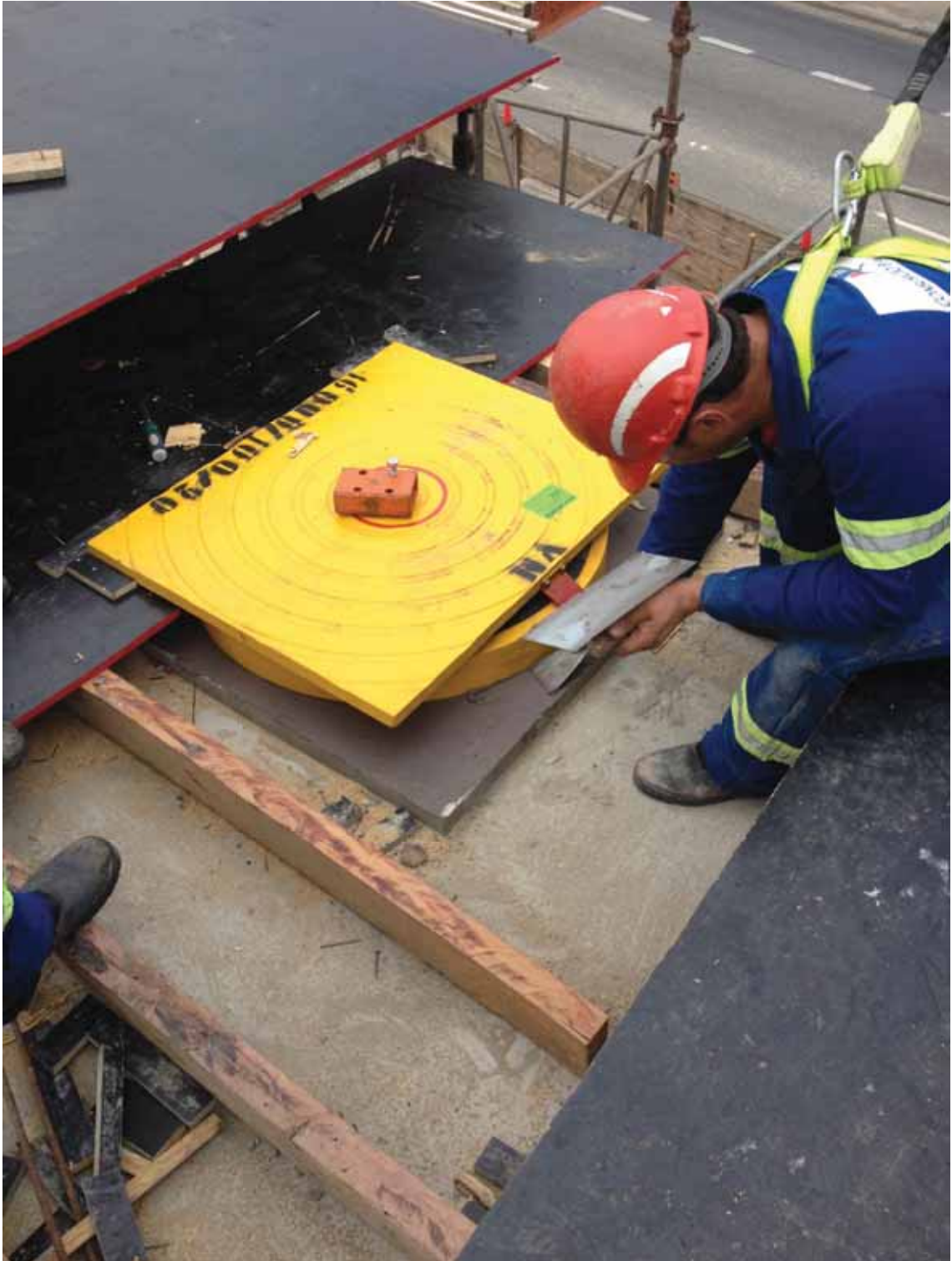
Foto 8 - Fase 4 - Montagem dos Aparelhos de apoio Vasoflon sobre o pilar AP6 [07/2015]
