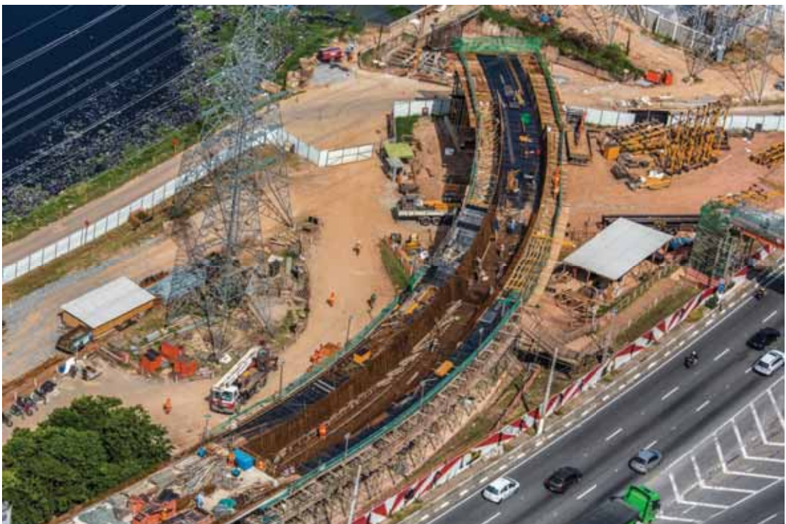
Foto 8 - Frente 1 - Ramo 100 - Fase 1: finalizada; Fase 2: montagem de armação; Fase 3: montagem de formas do vão entre AP2 100 e AP4 [04/2015]
