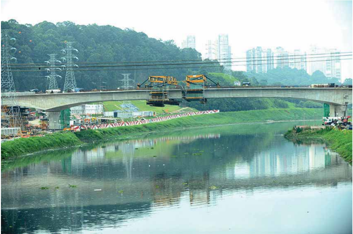
Foto 27 - Frentes 1 e 2 - Execução das aduelas de fechamento entre as frentes 1 e 2 [12/2015]
