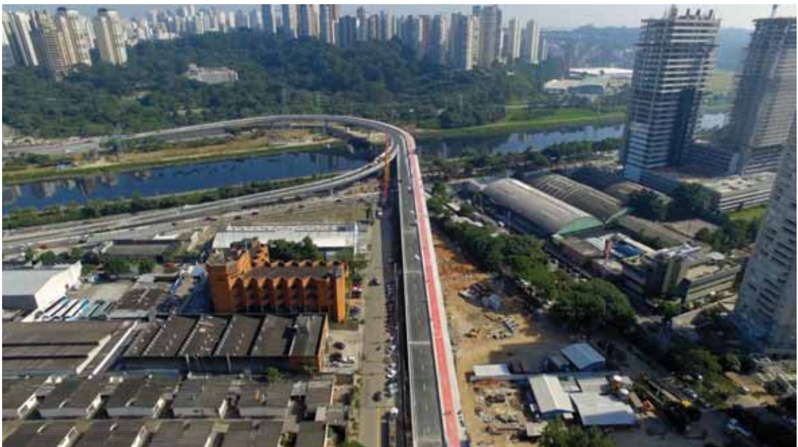
Foto 19 - Vista do acesso ao Ramo A [04/2016]
