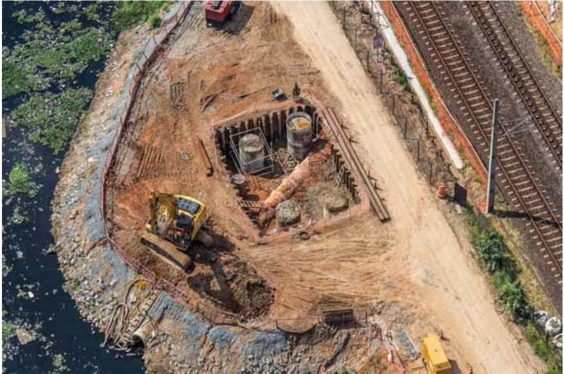
Foto 9 - Frente 2 - Execução do Bloco AP5 [04/2015]
