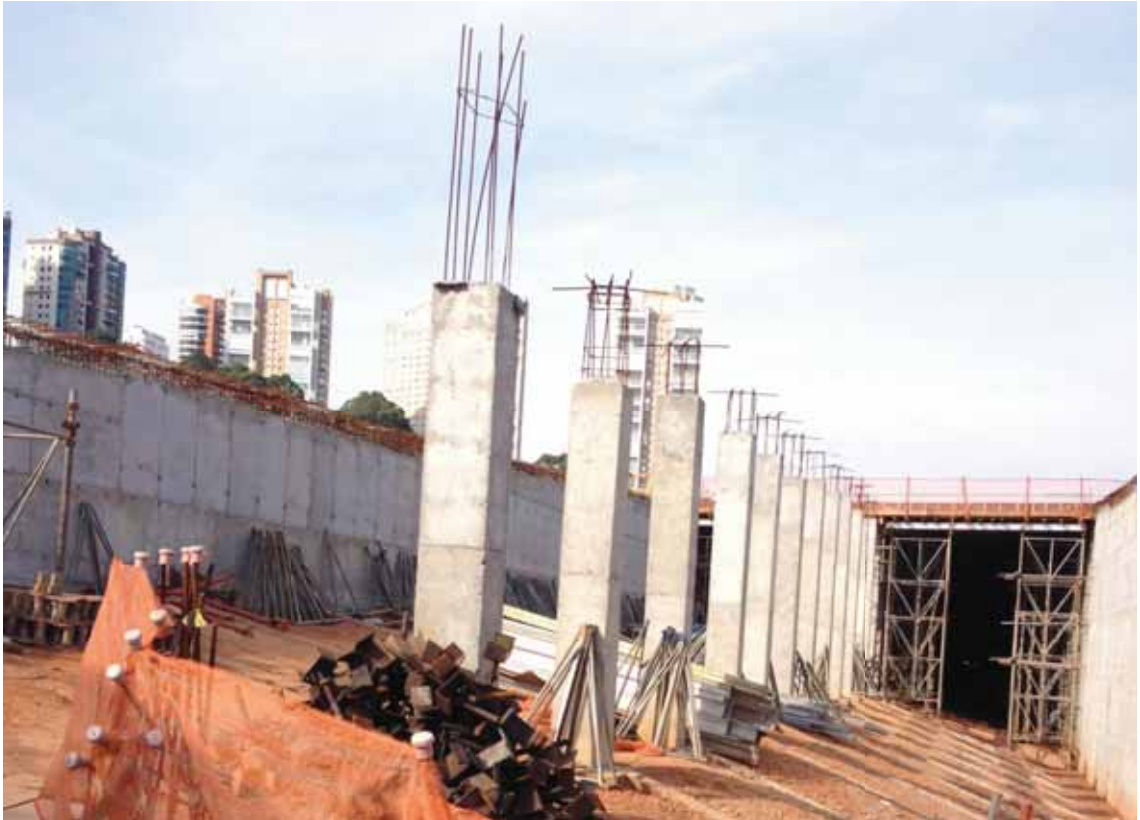
Foto 2 - Execução da Caixa 2 [12/2014]
