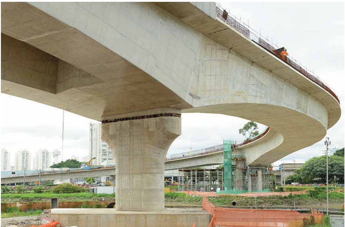
Foto 30 - Vista inferior do vão entre AP4 e AP5 [03/2016]
