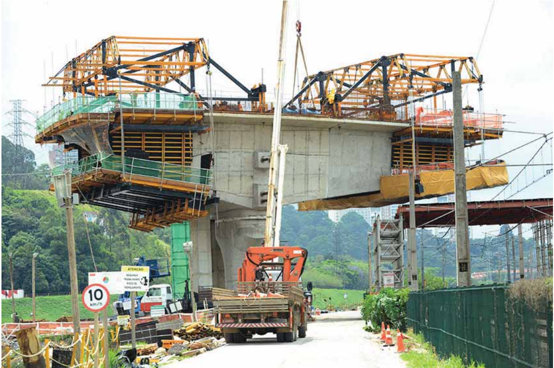
Foto 23 - Frente 2 - Fase 2 - Aduela 1 em direção ao AP4 e Aduela 2 em direção ao AP6 (Defasagem necessária para montagem do carro CVS) [09/2015]
