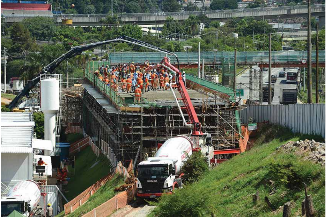
Foto 7 - Frente 1 - Fase 1 - Concretagem da laje superior do vão entre E3 e AP1 Ramo 100 [03/2015]
