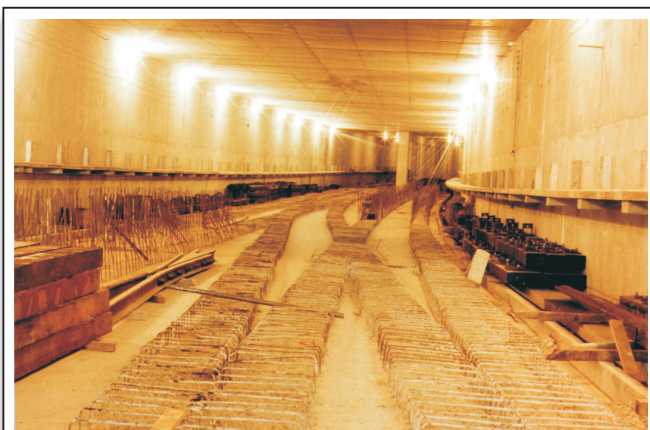
Foto Interior do Túnel
