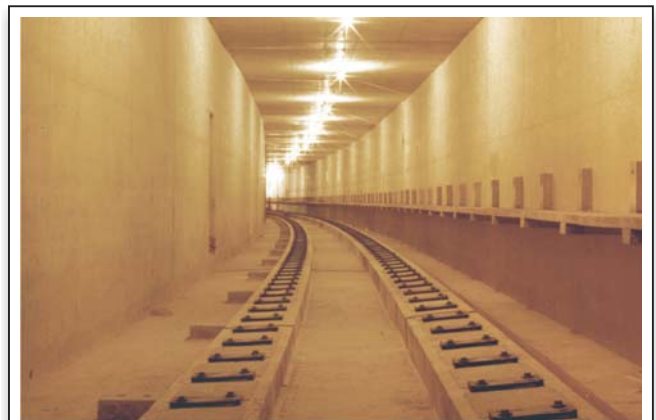
Foto Interior do Túnel
